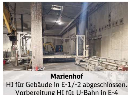
Rettungsschacht 03 Rohbau unter Druckluftvortrieb
