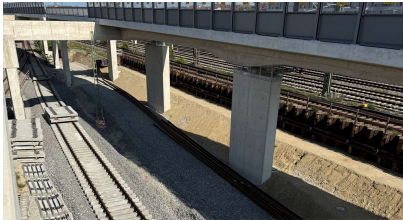
Oberirdisch West / Laim Grundsotter und Oberbau für Gleis 2/3 neu
